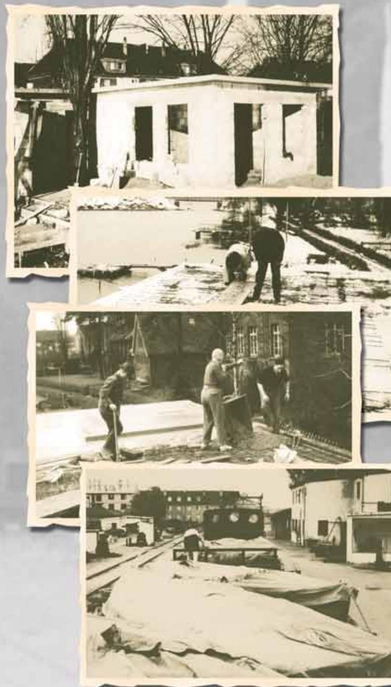
„unter Dach“ stehenden Gesamtanlage gearbeitet. Wegen des Frostes musste beim Innenbetonieren öfter mit Salzzusatz gearbeitet werden.
